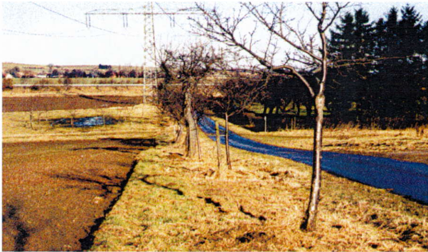
Abb. 10: Das Elzer Pumpwerk in der Senke, durch die früher der Oeseder Bach floß.
